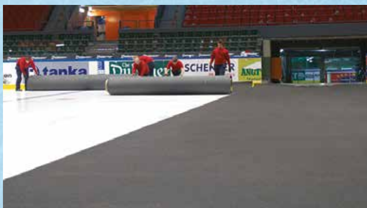
Mise en place des rouleaux cote à cote
